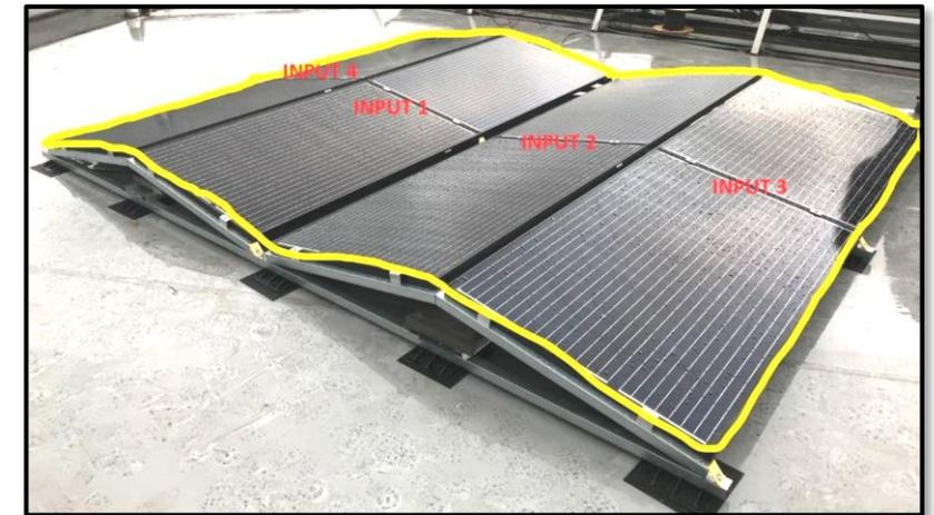
Nota: Los módulos conectados a la misma entrada del optimizador deben tener la misma inclinación y orientación
