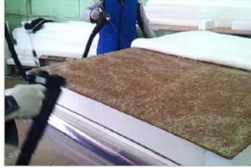
Manuel sprej uygulama
