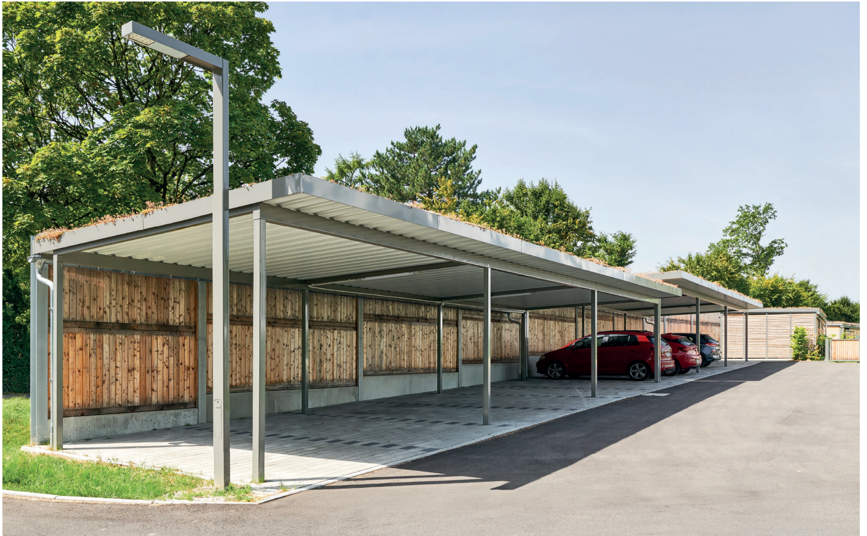
Carport mit Gründach, Rückwand bauseits.
