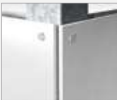
HPL Eckausbildung Die Platten werden mit farblich passenden Blindnieten sicher und dauerhaft auf der Stahlkonstruktion befestigt.
