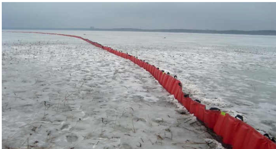
Пенонаполненные нефтеограждающие боны Lamog в ледовых условиях
