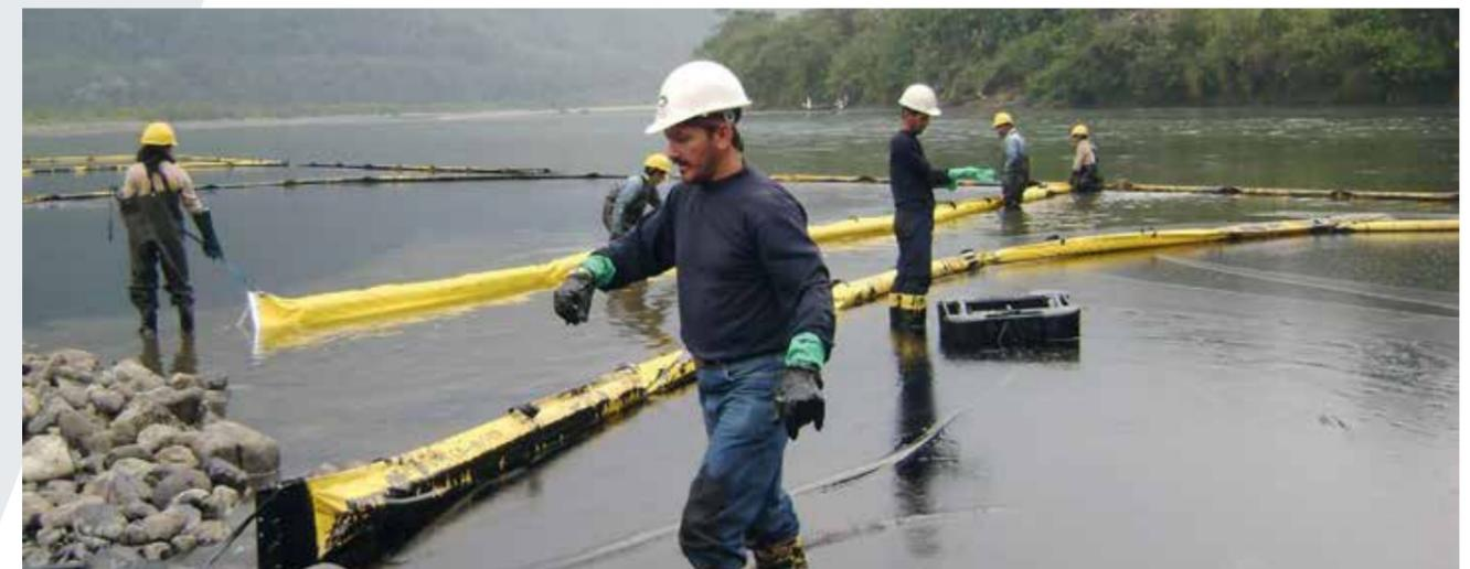
Barrera con flotador sólido, altura: 360-920 mm (14-36 pul.)
