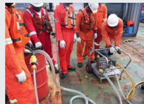
Despliegue del sistema dispersante a bordo de la embarcación
