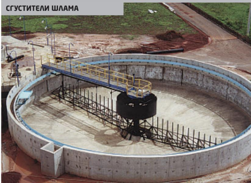
Помимо прочего, компания Lamor предлагает оборудование и комплексные решения для центров очистки промышленных и бытовых сточных вод. Среди предлагаемых продуктов и решений, например, очистители и сгустители шлама, а также технология
