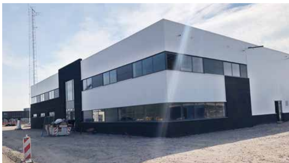
De bouw van de nieuwe onderhoudshub in IJmuiden vordert gestaag.
