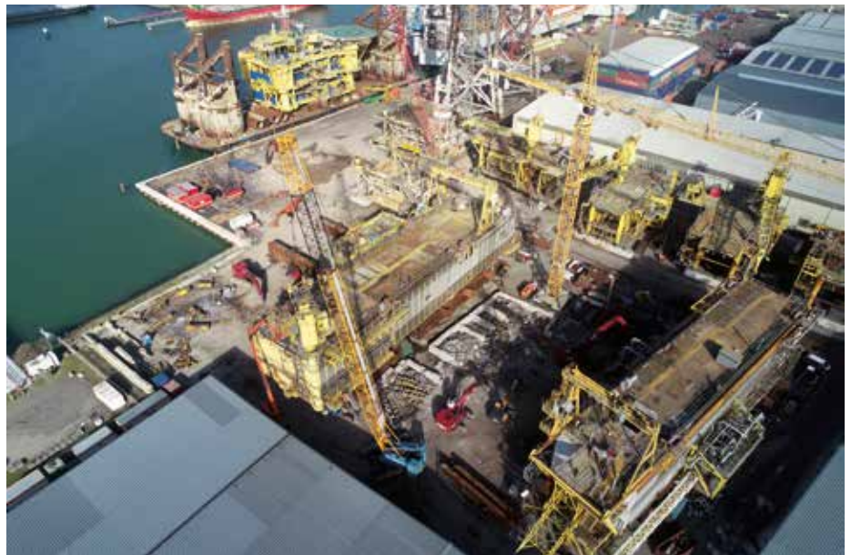
Sagro krijgt een toenemend aantal aanvragen voor decommissioning.
