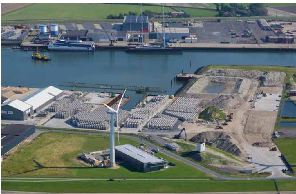
Levvell fabriek, project versterking/verbreding afsluitdijk.
