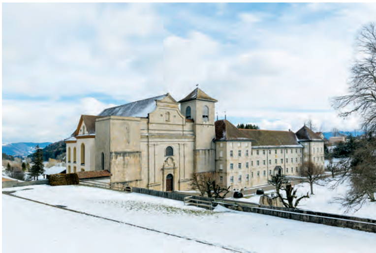
Im stumpfen Nordturm der Abteikirche von Bellelay verbirgt sich ein neuer Lift.
