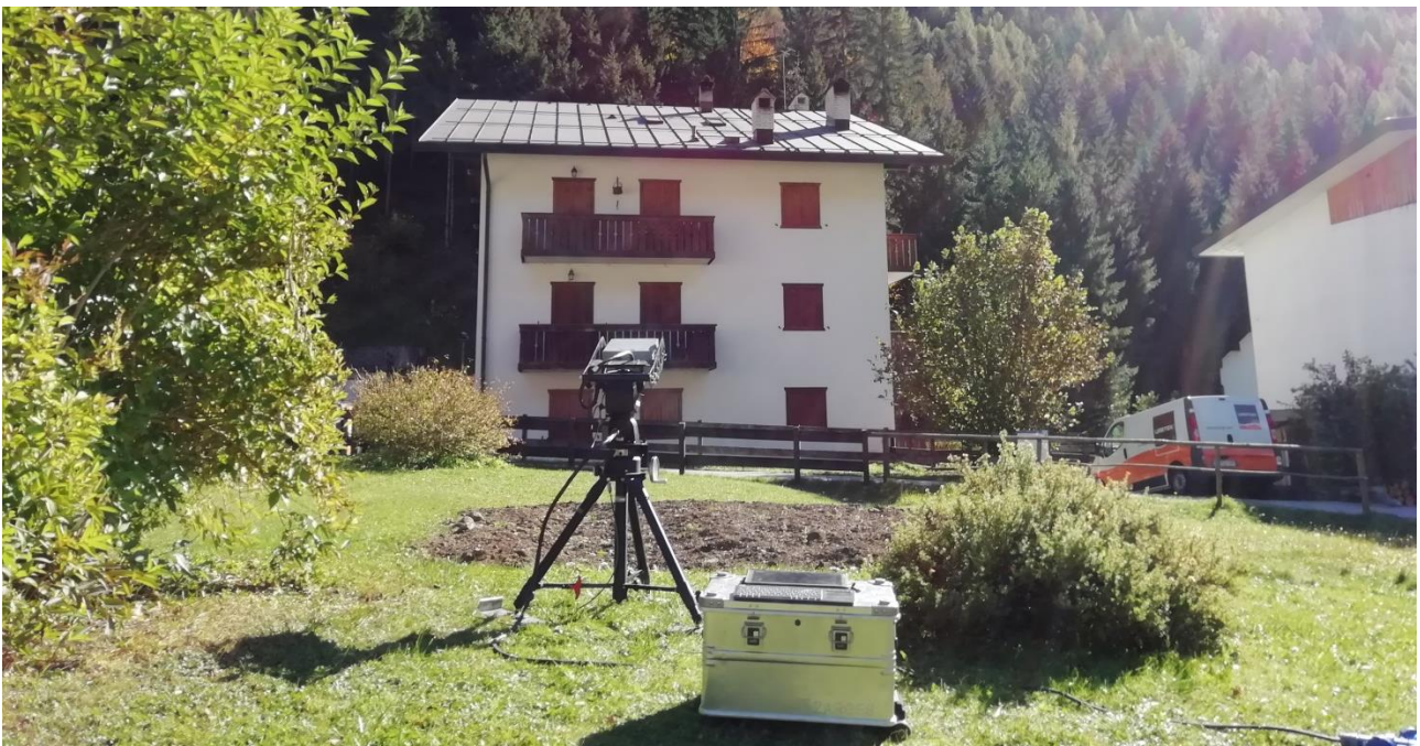
Figura 2-2: Posizionamento del radar per il monitoraggio della facciata Ovest
