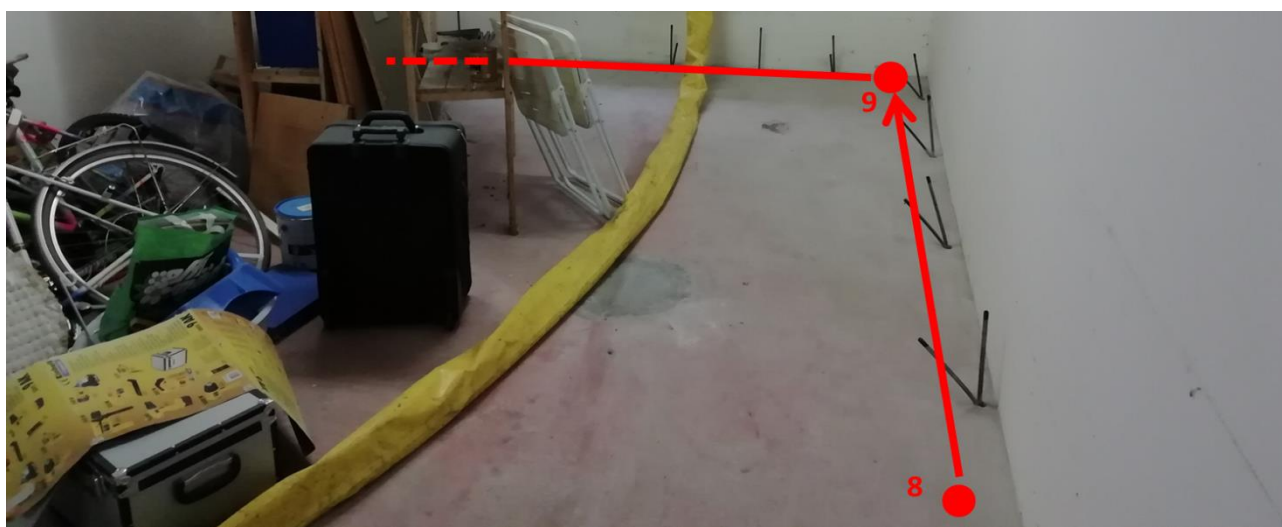
Figura 2-14: Facciata interna con profilo iniezioni 8-9 e parte del tratto 9-10
