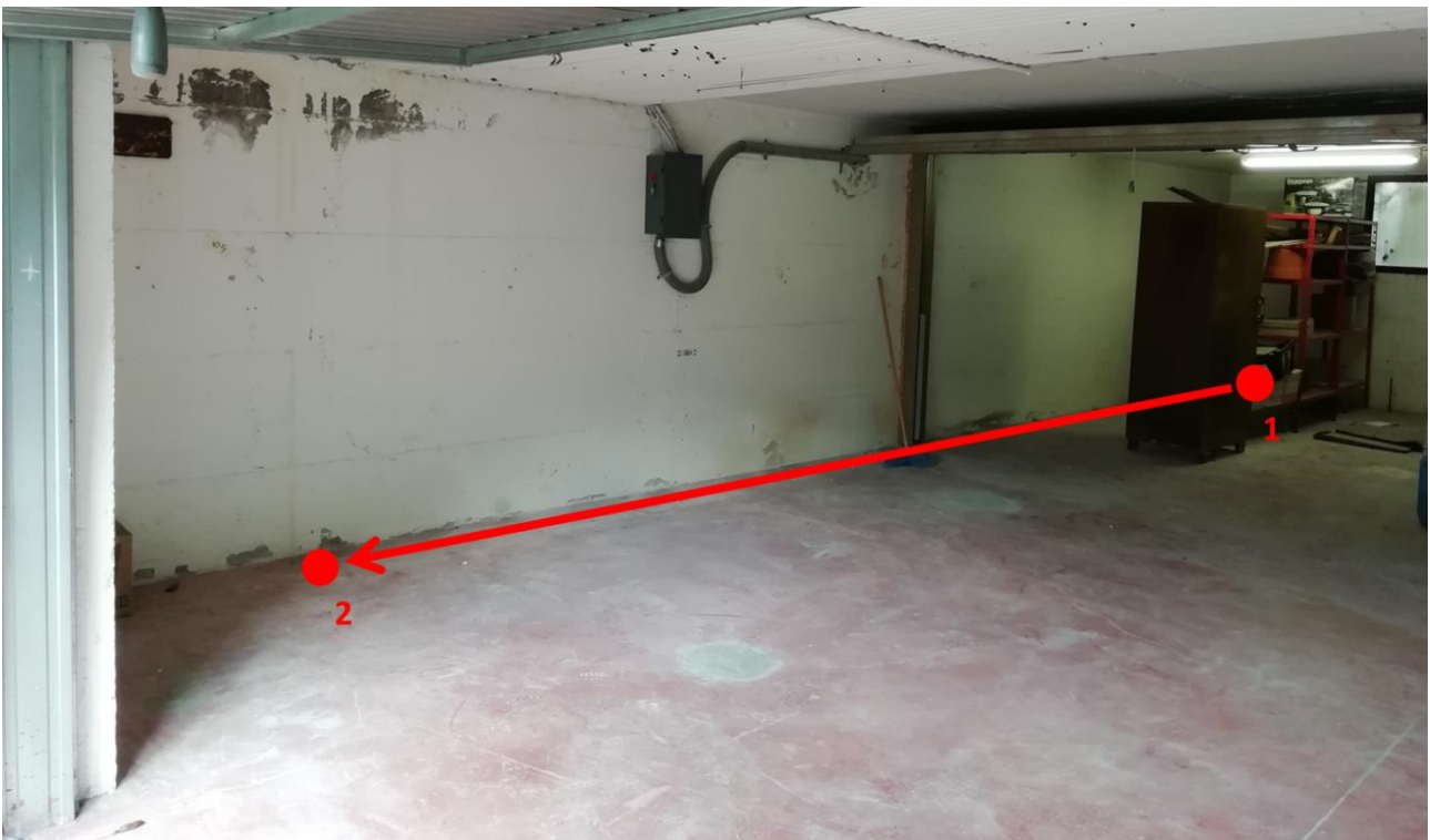
Figura 2-4: Facciata interna con profilo iniezioni 1-2
