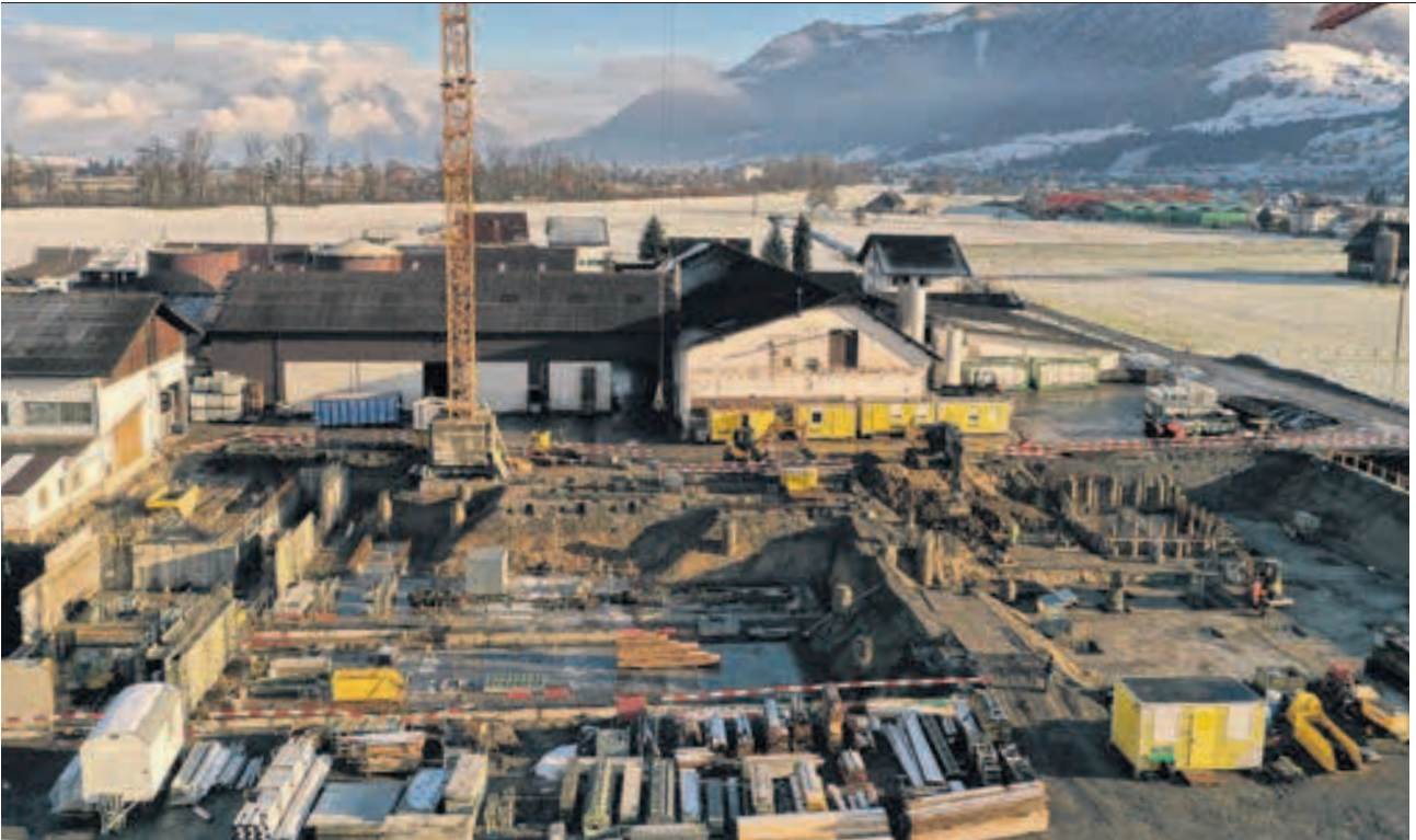
Der Bau des Energiezentrums Ausserschwyz in Galgenen macht täglich Fortschritte.
